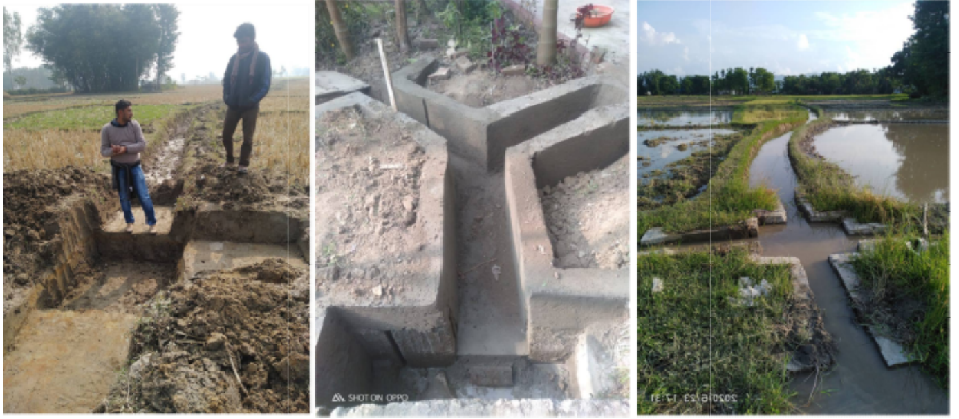
फोटो : शाखा नं.१ को JICA-TCP/PIAT कार्यक्रमको पाईलट साईटमा निर्माण गरिएको पानी बाडफाड गर्ने संरचनाहरु
