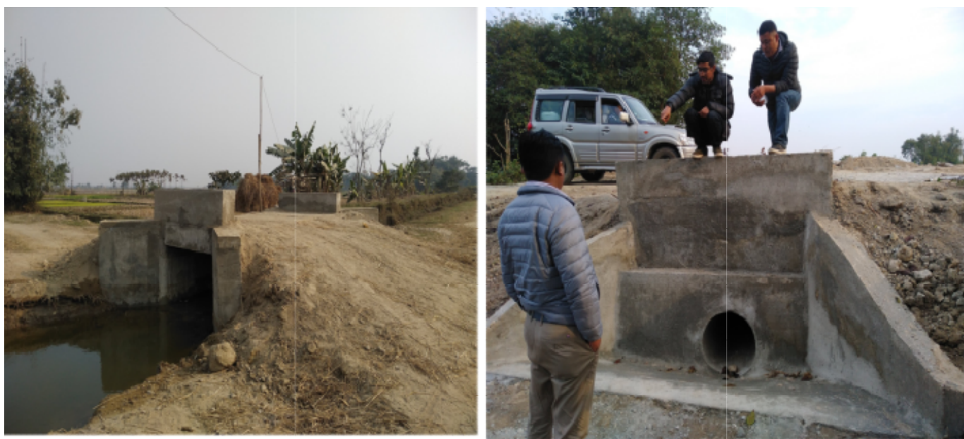
फोटो : शाखा नं.८ र शाखा नं. १० मा निर्माण गरिएको Box culvert and CD संरचना
