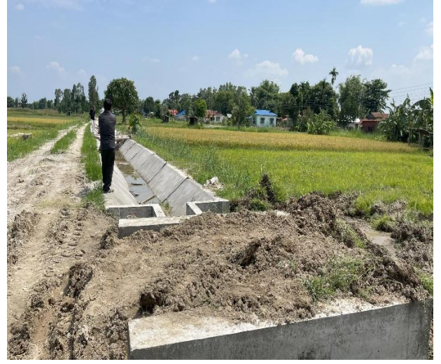
फोटो : प्रशाखा तथा उपशाखा नहरहरु मर्मत तथा निर्माण कार्यहरु
